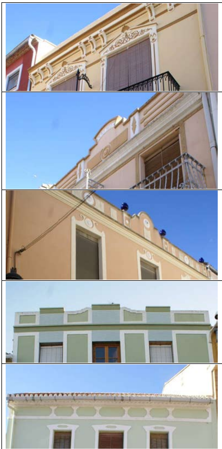
Remates de Fachada
