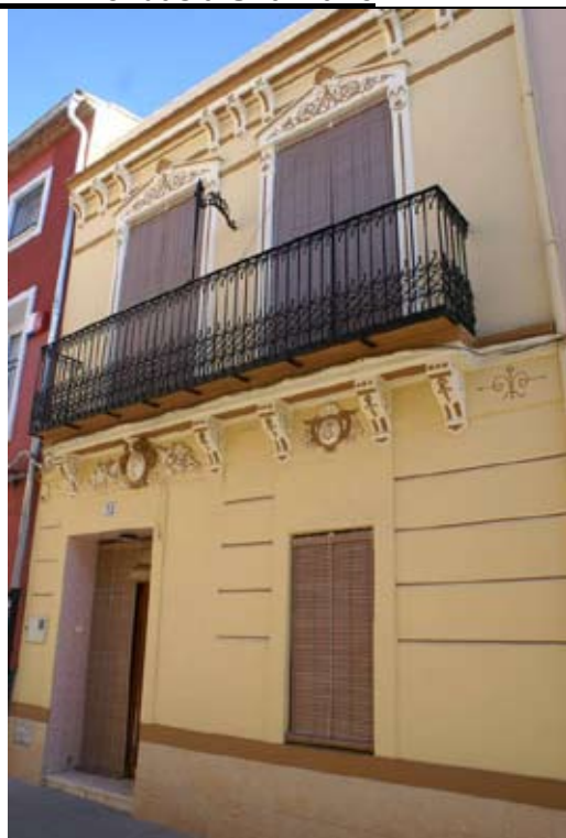
CALLE MAYOR N° 21 (Balcón a dos huecos)
